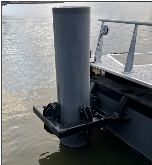
Figur 22 Exempel grov stålrörspåle med pålkrage för förankring vid stora djup (t.v) och enklare ankarrör för förankring vid grunt vatten (t.h).
