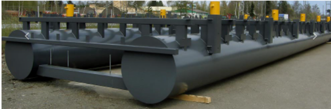
Figur 12 Exempel på stålponton med samverkande ramverk
