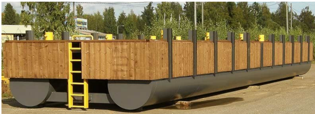
Figur 13 Exempel på stålrörsponton kompletterad med träöverbyggnad, räddningsstege och belysning.
